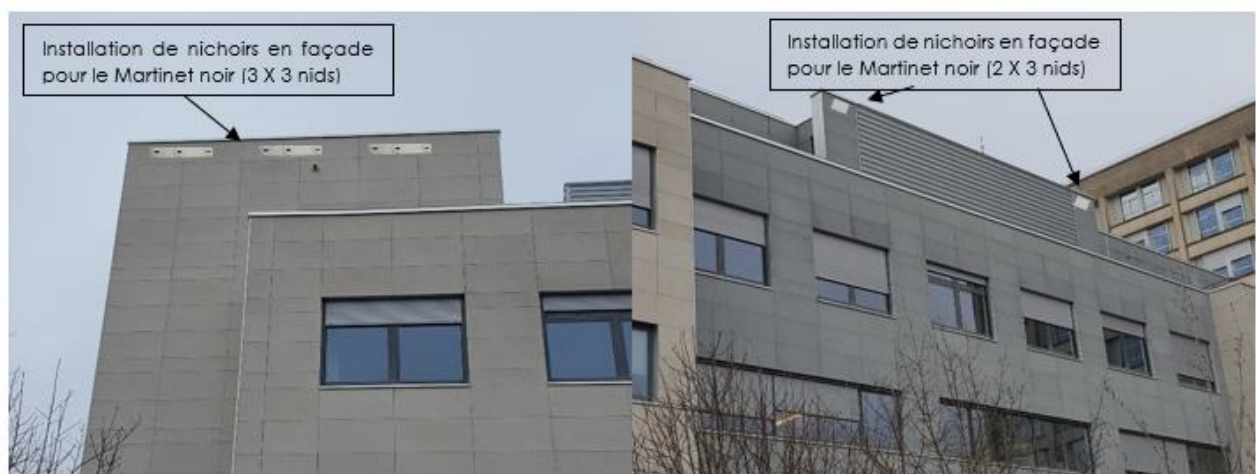
Façade EST du bâtiment BMT-HC
