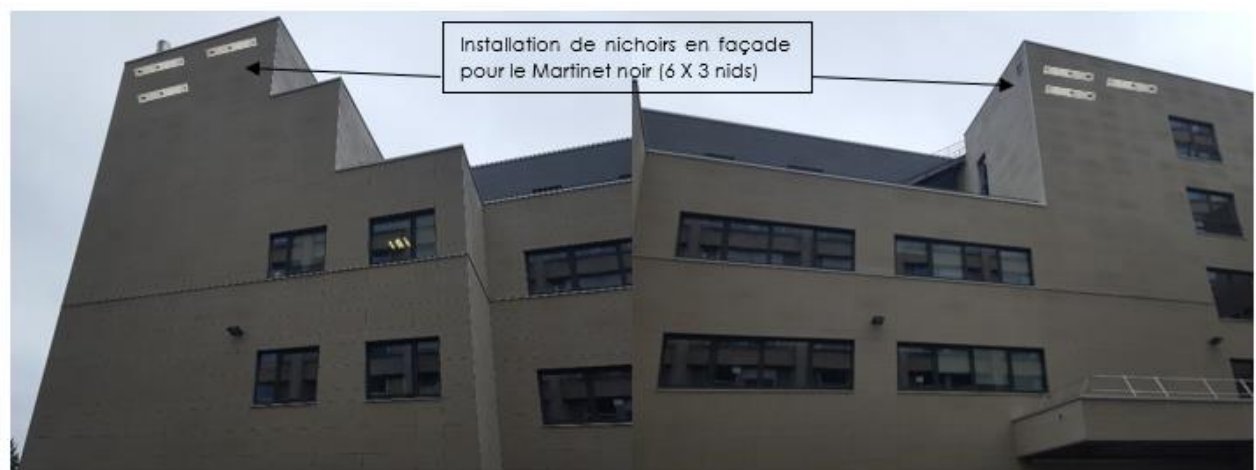
Façade NORD du bâtiment BMT-HC
